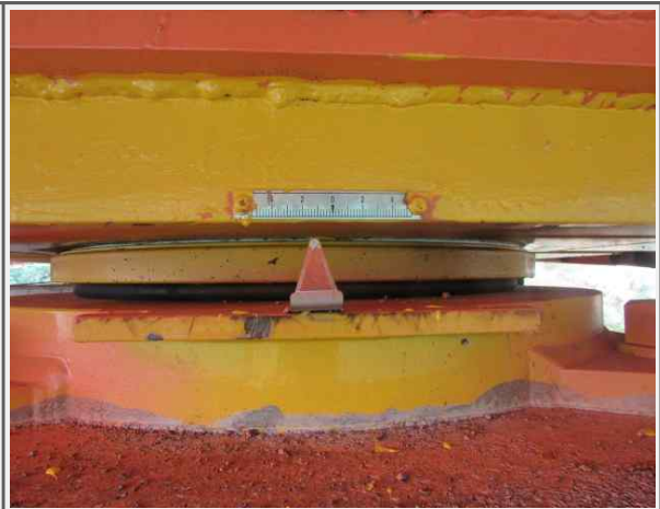
P3 교량받침 이동량 측정(영천)
