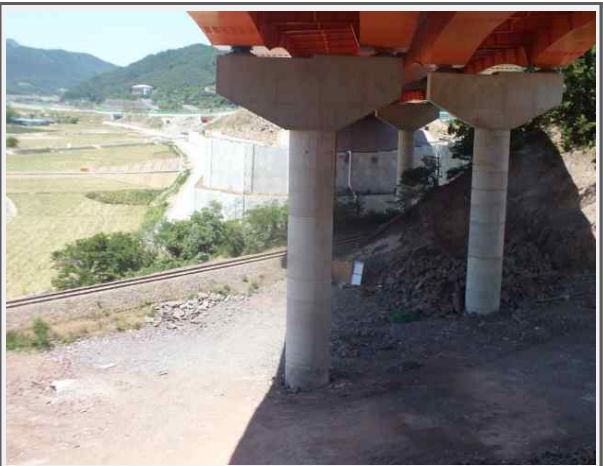
교각 전경 (P2)
