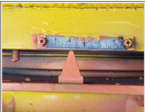
A2 교량받침 이동량 측정
