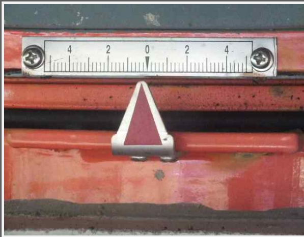
A1 교량받침 이동량 측정(상주)
