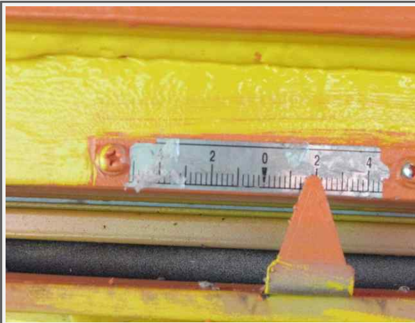
P1 교량받침 이동량 측정(상주)
