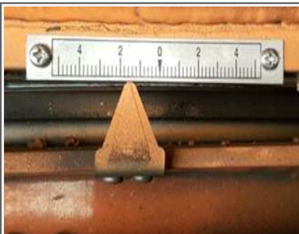
A2 교량받침 이동량 측정
