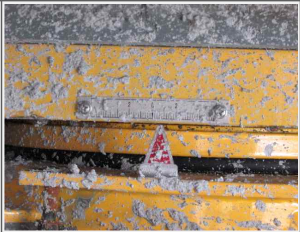
A1 교량받침 이동량 측정(영천)
