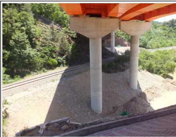
교각 전경 (P1)
